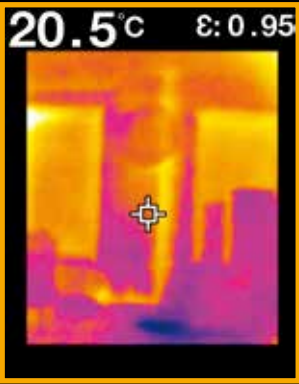
墙体内发热管道
