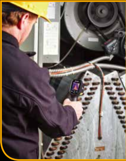
暖通空调(HVAC)检查
