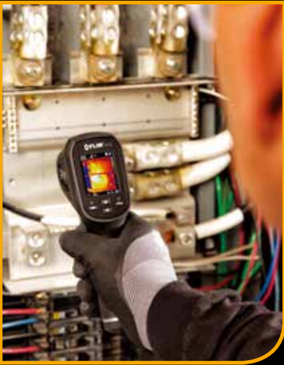
电气故障检修
